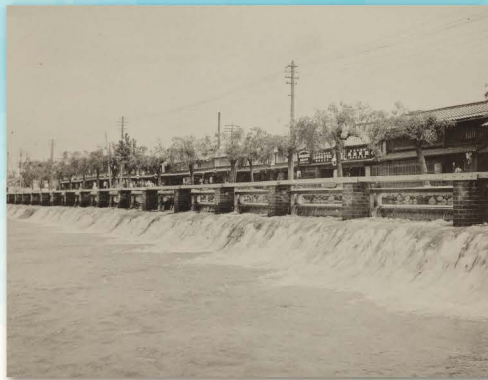
孫橋放水所 【明治45(1912)年5月】
